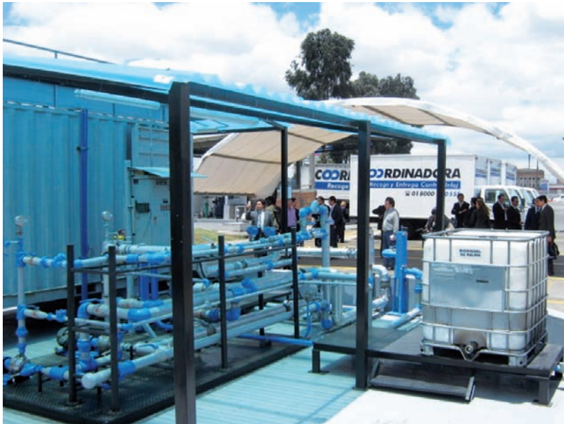
Estación de almacenamiento y mezcla de biocombustibles durante las pruebas de larga duración con biodiésel de palma en una flota de camiones de transporte.
