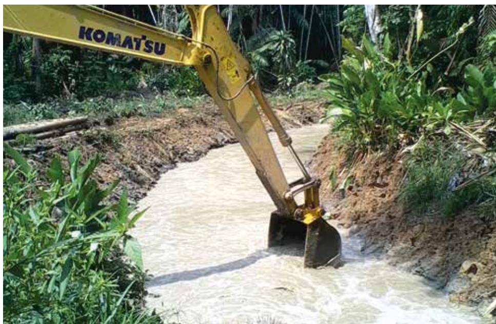
Figura 5. Obras civiles de intervención o mantenimiento de drenajes naturales.
