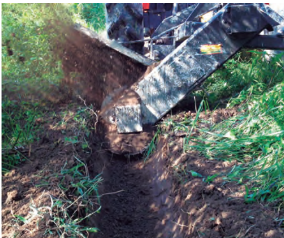
Drenaje superficial realizado con el Ditcher. Foto: Juan Manuel Guerrero.
