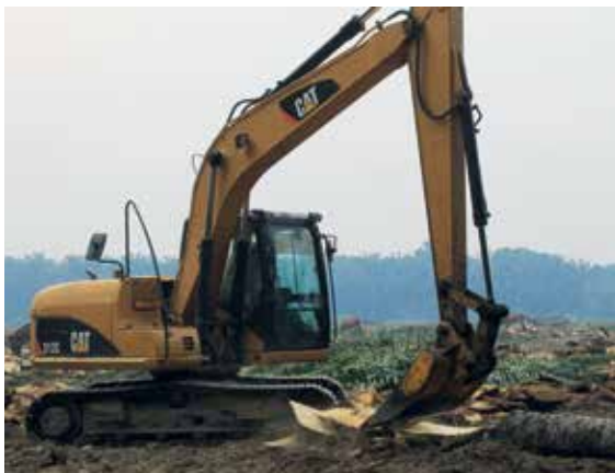
Figura 6. Eliminación mecánica con excavadora. Fuente: Mesa de Trabajo sobre PC-HC
