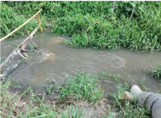
Figura 9. Construcción de trinchos inadecuados en drenajes. Fuente: Mesa de Trabajo sobre PC-HC
