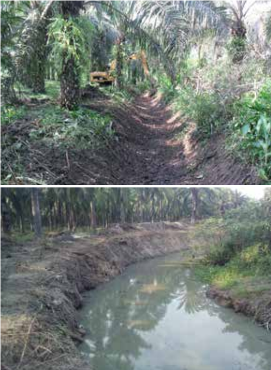
Figura 10. Construcción y mantenimiento permanente de drenajes. Fuente: Mesa de Trabajo sobre PC
