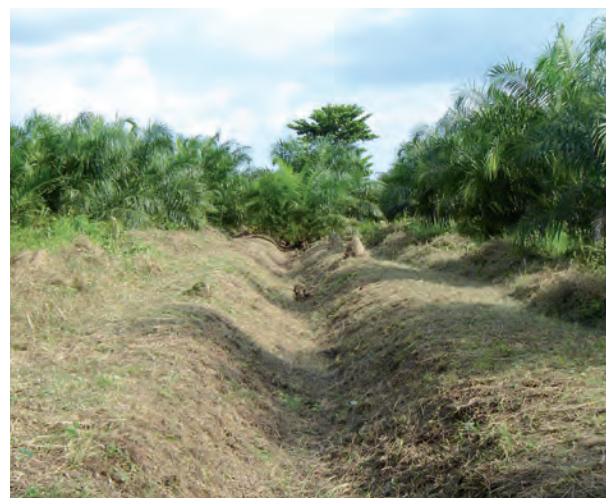
Figura 47. Vegetación recortada mecánicamente en plantilla, talud y borde del canal.
