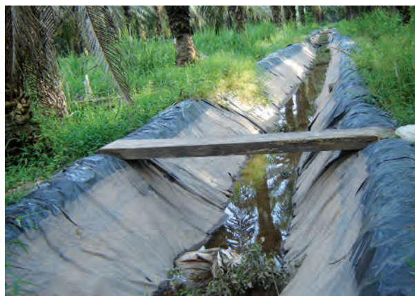
Figura 48. Revestimiento de canal con plástico.
