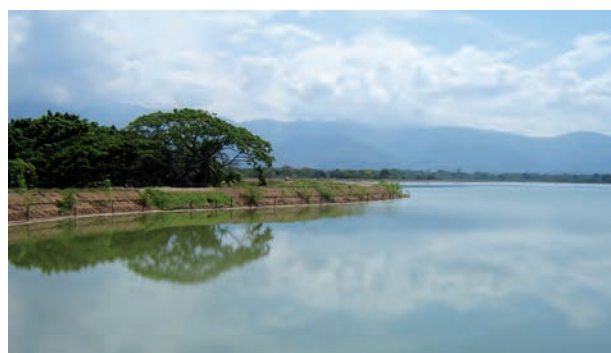
Figura 55. Embalse construido para riego.
