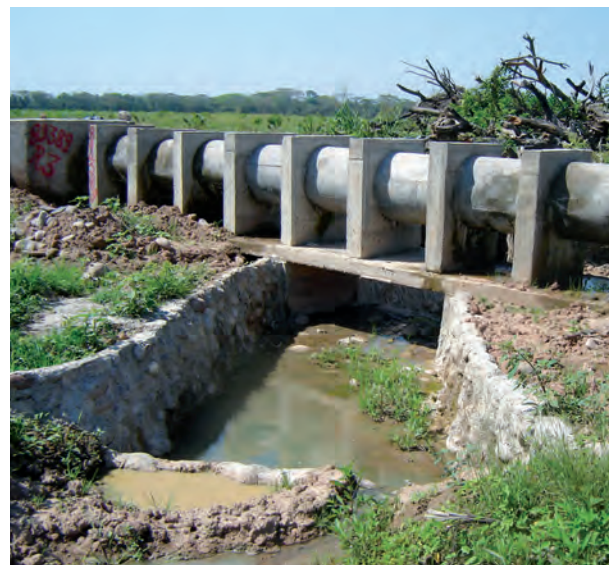
Figura 51. Paso elevado con tubo de cemento.
