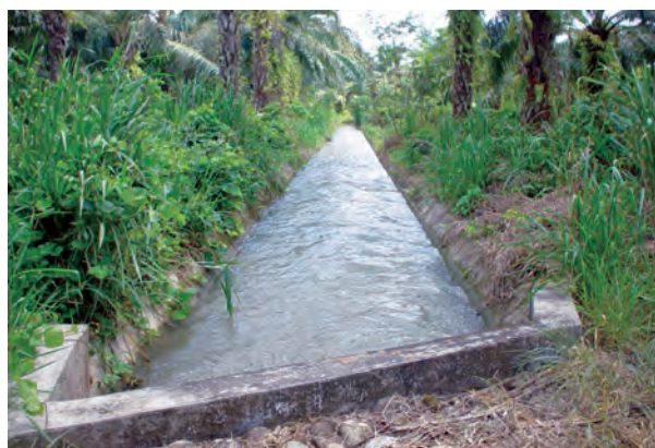
Figura 49. Revestimiento de canal con cemento.
