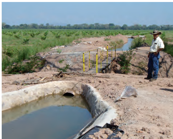
Figura 50. Paso elevado con tubo metálico.
