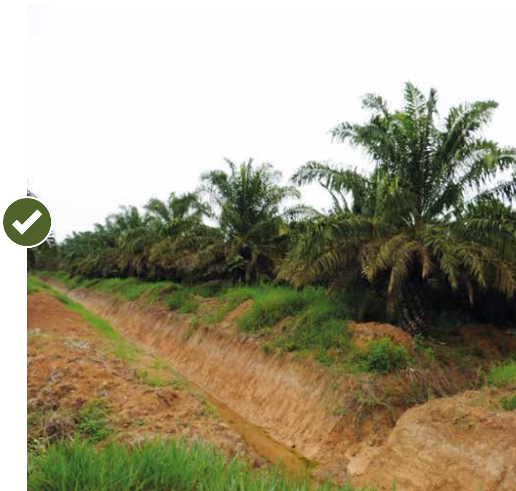
■ Construcción de drenaje de alivio. Foto: Pérez, P.
