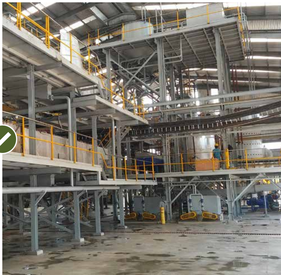
■ Esterilizador continuo de una planta de beneficio de aceite de palma. Foto: Ramírez, N.
