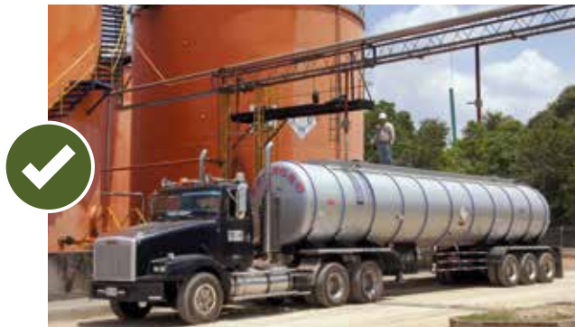
■ Tanques metálicos para almacenamiento de aceite de palma crudo. Foto: Fedepalma
