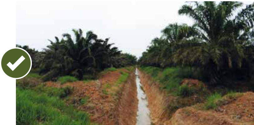
■ Drenaje en buen estado de mantenimiento. Foto: Pérez, P.
