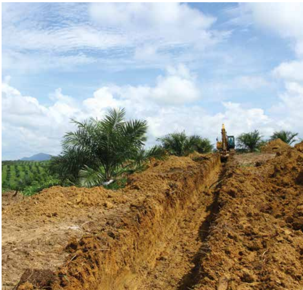
■ Construcción de un canal para riego. Foto: Fedepalma
