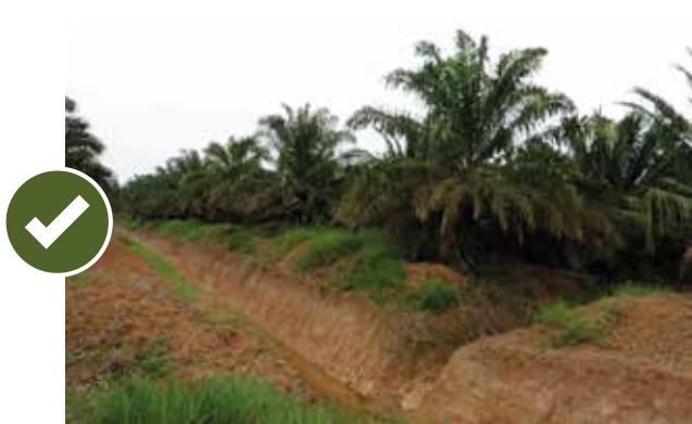
■ Construcción de drenajes. Foto: Pérez, P.
