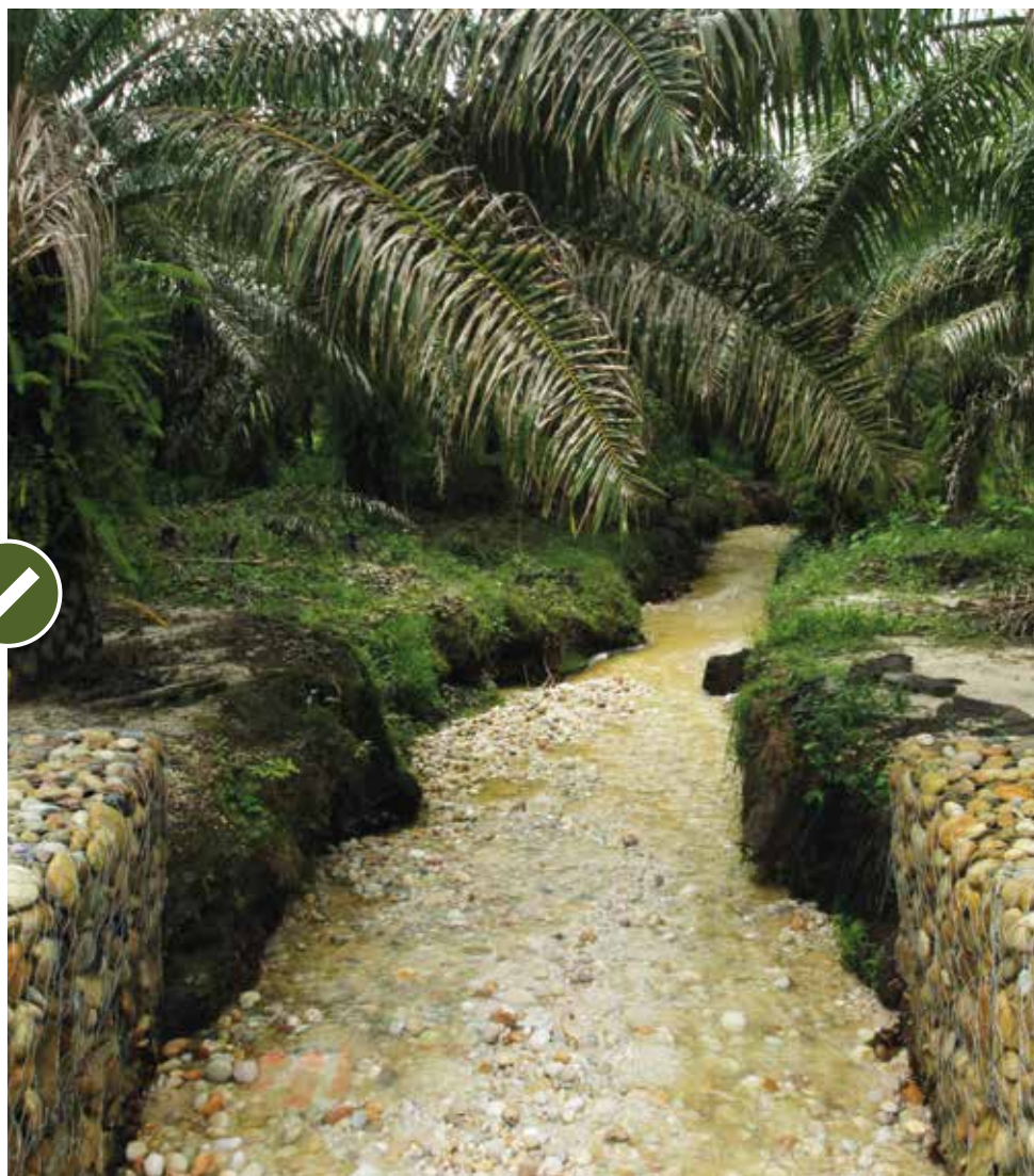
■ Canal interno de riego con construcción de cárcava de protección. Foto: Fedepalma
