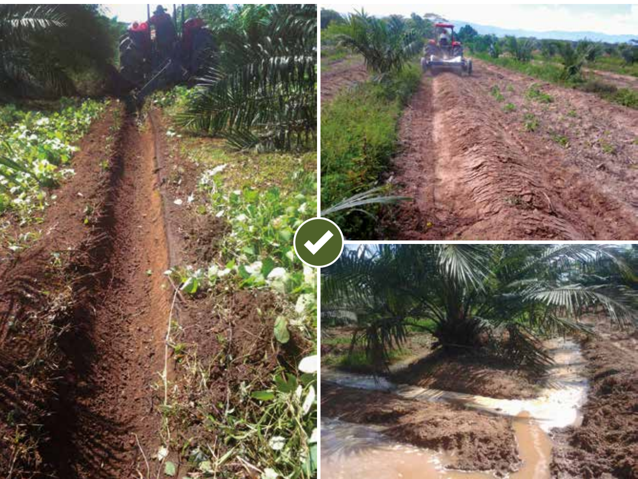
■ Construcción de surcos con ayuda de zanjeadores mecánicos (ditcher y taieadora). Fotos: Mercado, A.
