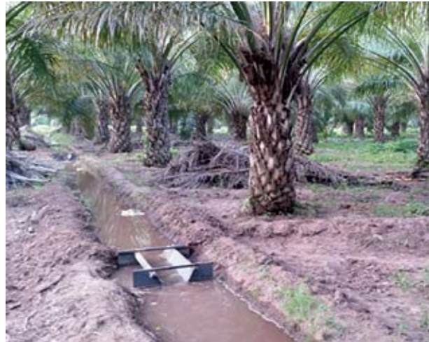
Figura 36. Instalación de instrumentos de aforo (RBC) en los puntos evaluados
